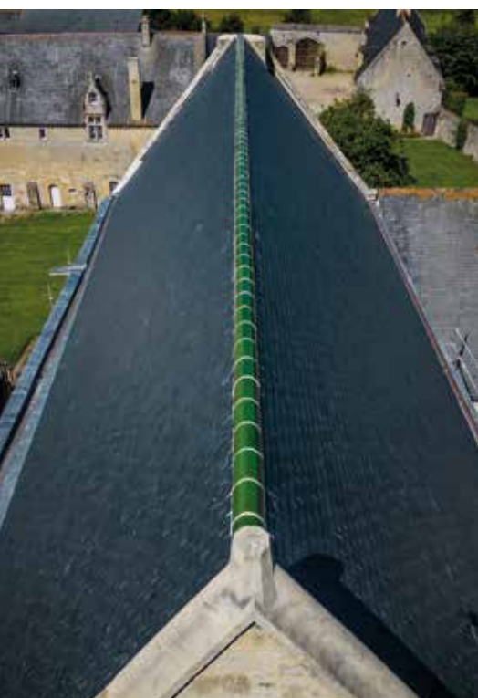
Voûtes, reins de voûtes ont été repris. Les murs ont été consolidés à l'aide de tirants métalliques. Quant au toit, il a été refait avec 16 types d'ardoises différents.
