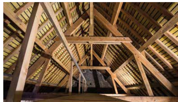
La pose de la nouvelle charpente de l'église a permis la stabilisation générale de l'édifice.
